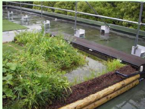
雨水池がメインの緑化の一例です。 木箱部分が雨水貯留タンクになっており、 タンクと池の相互送水設備が付いています。
